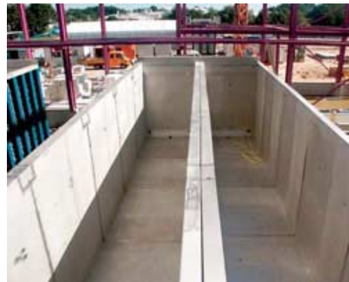
Für den Bereich der Vorbehandlung: Installation von zehn Aktiv-Behandlungszonen mit Badgrößen von bis zu 220 m 3
