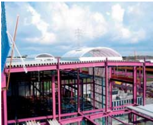
Blick auf die Baustelle: Die größte industrielle Beschichtungsanlage Europas steht im Emsland auf einer Grundfläche von ca. 100 x 100 m und hat eine Bauhöhe von ca. 20 m
